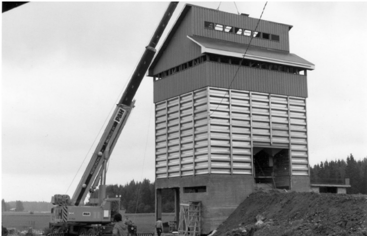
Rakentamisen taidot ja tekniikka ovat nopeasti kehittyneet. Kuvissa Esko Maaronen ja Martti Santala ovat rakentaneet Risto Järvisen uutta kuivuria vuonna 1979. Siinä maassa rakennettu katto-osa nostetaan nosturilla ylös paikoilleen.
