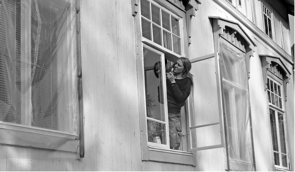
Seurakuntatalon ikkunoita on korjattu perinteitä kunnioittaen Emilia Perhon toimesta.
