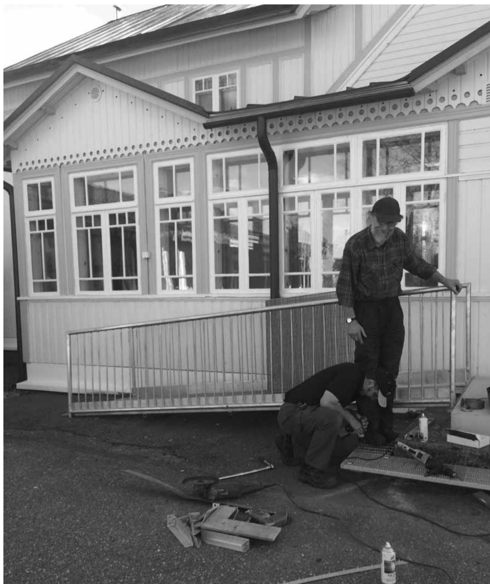
Seurakuntatalolle pääsee nyt rollaattorillakin. Ramppia asentamassa Martti Heikkilä ja Kari Rekikoski. Kuva Outi Tukia-Takala.
