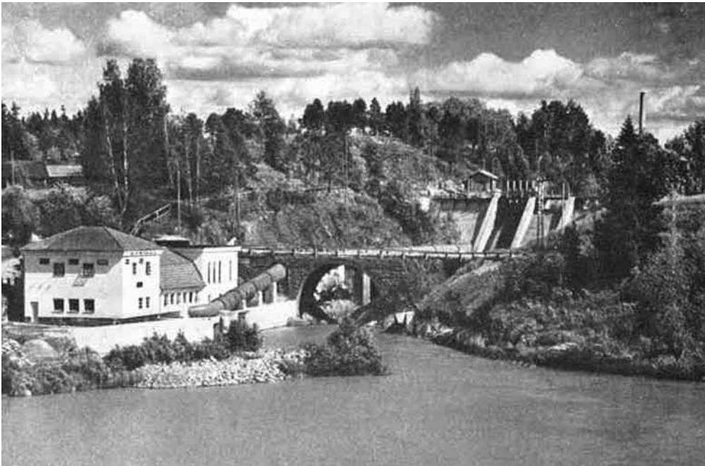
Juvan voimalaitos 1950-luvulla. Kuva Lounais-Suomen Sähköyhtiön 50-vuotishistoriasta.
