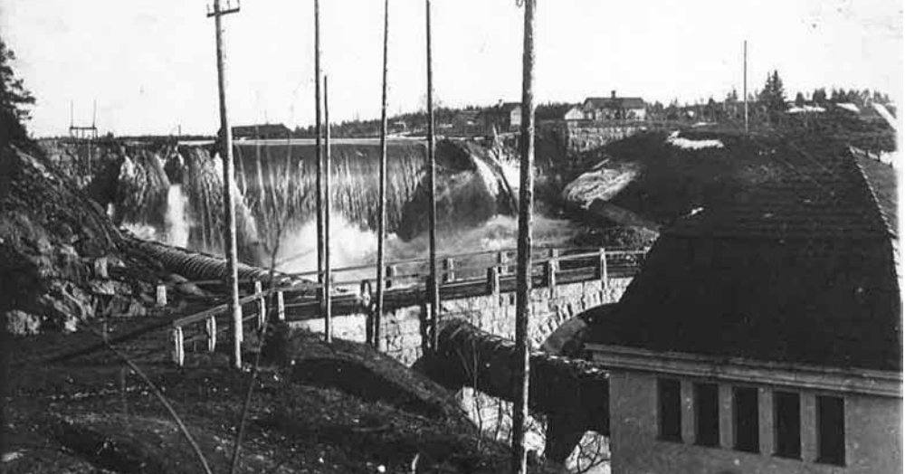
Kuva rajusta kevättulvasta huhtikuussa 1916. Tehdasrakennus on jo tehty, mutta padon ylärakenne on vielä tekemättä. Kuva Sulo Heino.
