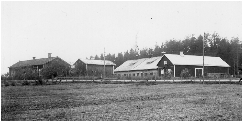
Jaakolan tilan rakennukset vuonna 1935 ennen uuden päärakennuksen rakentamista. Kuva Alpo Tähtinen
