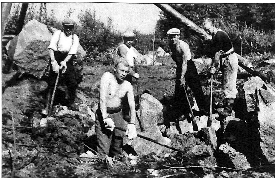
Linnoitustyömaan miehet kiviä halkomassa ja siirtämässä panssarivaunuesteeksi puolustuslinjaan Kuolemajärvellä kesällä 1939.
