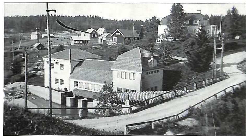
Juvan voimalaitos 1930-luvun lopulla. Itse tehdas oli tällainen vielä talvisodan aikana, sillä ns. iso kone asennettiin vasta jatkosodan vuosina 1942-43. Tällöin rakennuksen sillan puoleinen pää muutettiin tasakattoiseksi. Myös suuri vesitunneli louhittiin kalliosta laitosrakennuksesta padolle. Kuva Margit Tövion kokoelmista.
