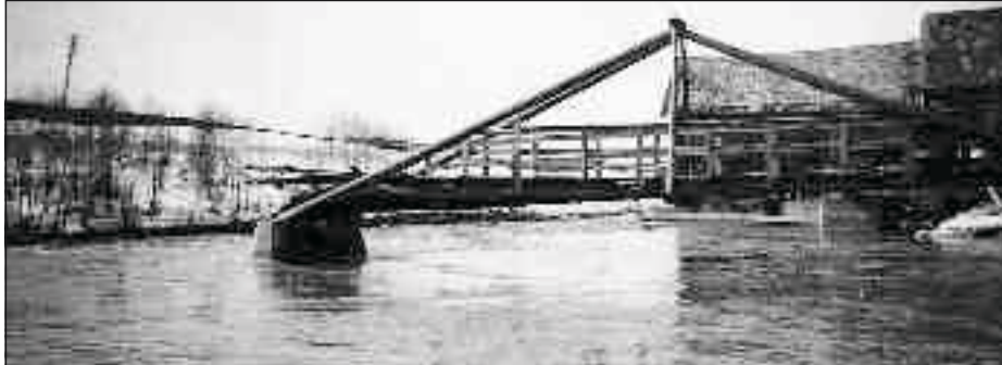
Viimeinen kuva kosken yli rakennetusta portaasta, josta kevytliikenne kulki Alikulmalta Euralle ja päinvastoin. Keväiset tulvat jääneen rikkoivat paljon käytetyn sillan. Kuva: Henna Raininko.
