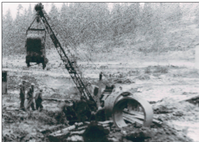
Ojaan suistunut kaivinkone Turun kaupungin viemärityömaalla vuonna 1957. Kuva Tauno Evesti.
