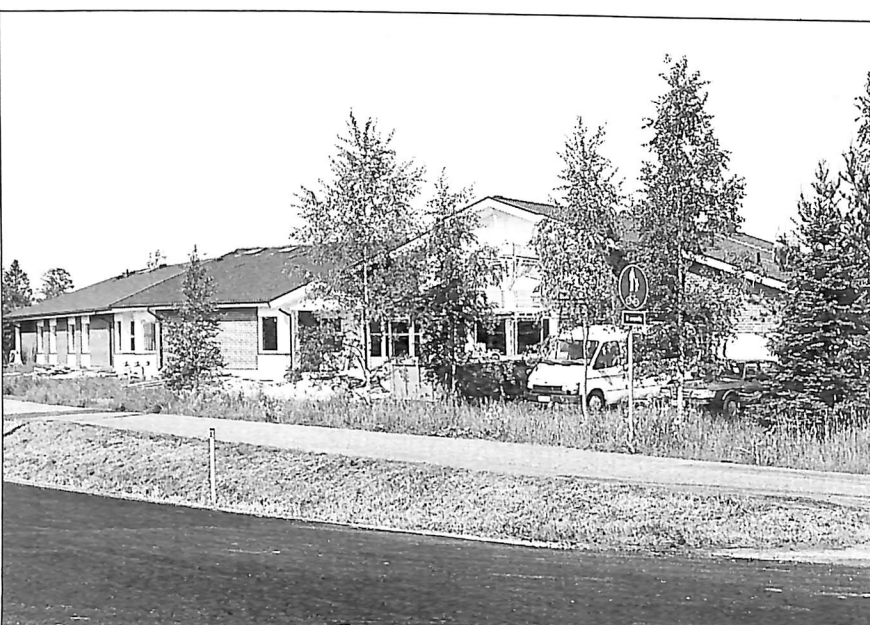
Valmistumassa oleva palvelukeskus julkisivultaan.
