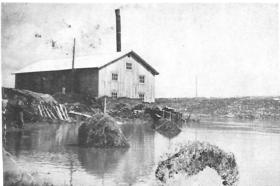
Seppälän ensimmäinen tiilitehdas suuren kesätulvan aikaan heinäkuussa 1954.
